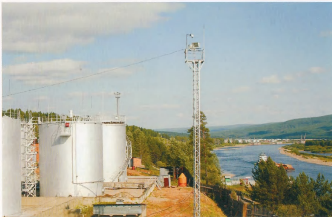
Резервуарный парк нефтебазы
