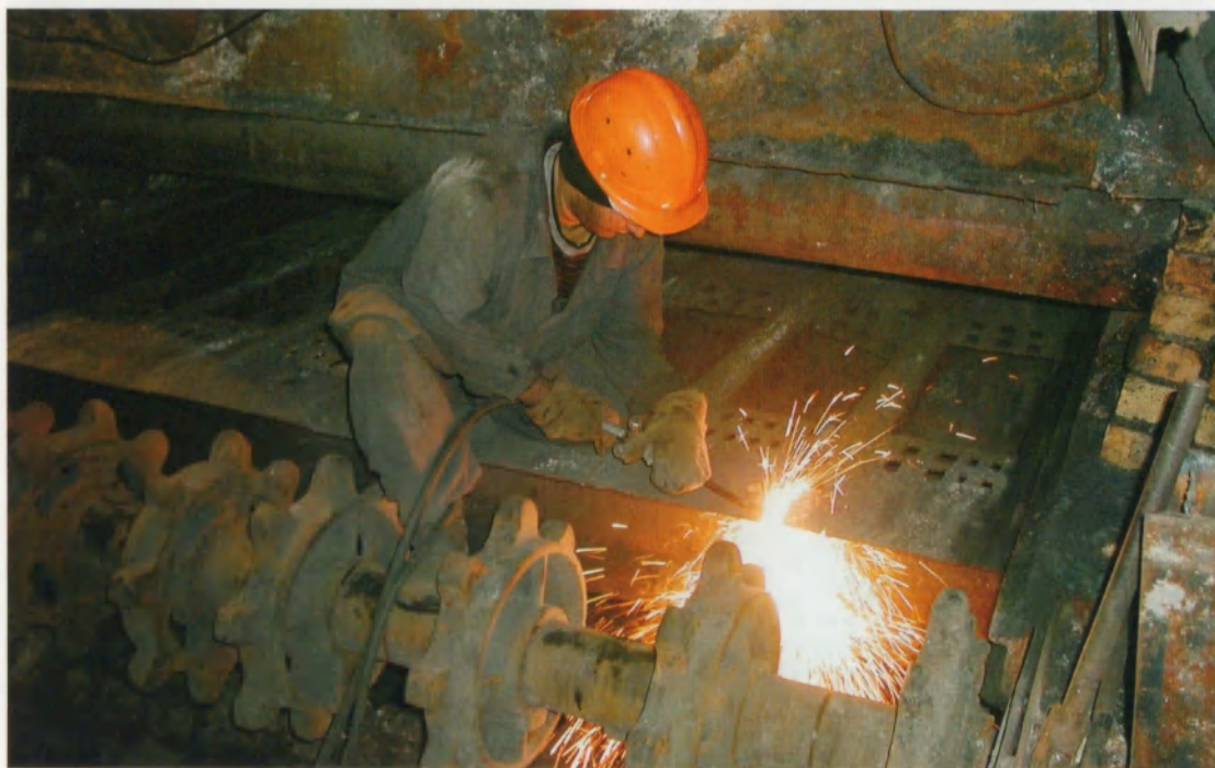
Усть-Кут. Подготовка котлов к зиме
